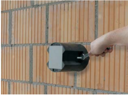
Versetzen der Universalmontageplatte UMP®-ALU-TZ.
