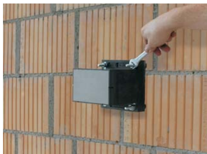
Versetzen der Universalmontageplatte UMP®-ALU-TQ.
