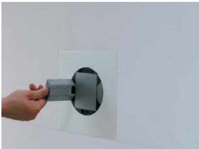
Versetzen der gefrästen Dämmplatte, danach Dämmplatten fugenfrei anpassen und Formteile aus EPS einpressen.
