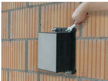
Versetzen der Universalmontageplatte UMP®-ALU-TR.
